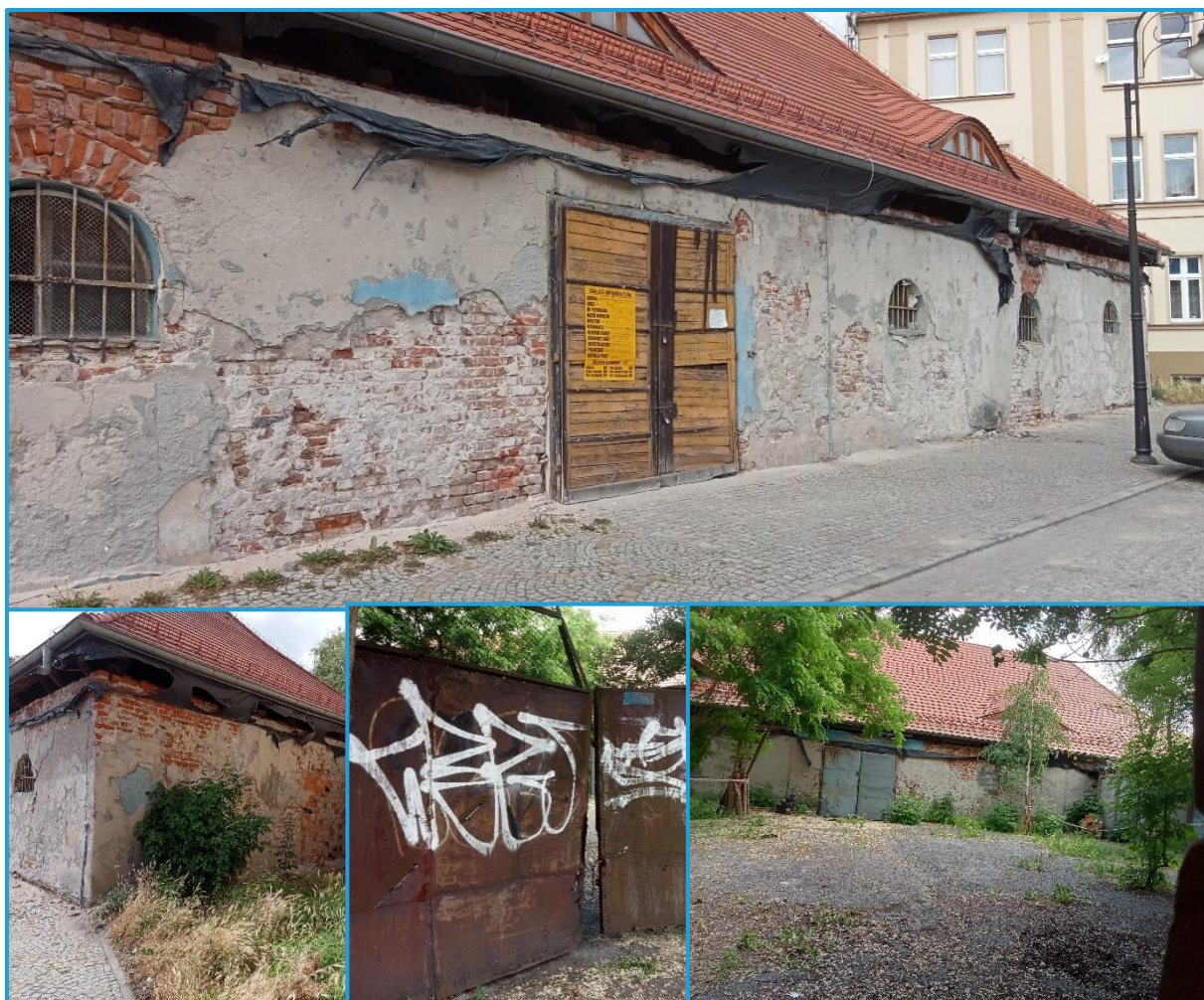
Rysunek 17. Stan techniczny Magazynu Solnego (Plac Solny 1) i najbliższego otoczenia
