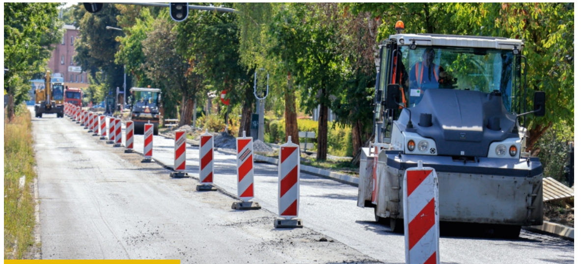
Przebudowa ulicy Głogowskiej warta jest ponad 23 mln zł
