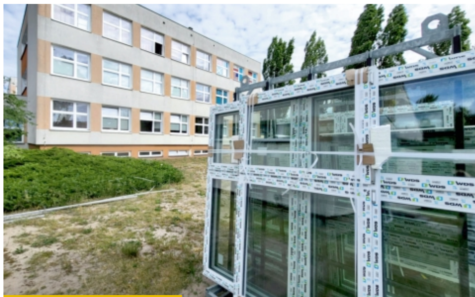
„Ósemka” przechodzi kilka etapów wielkiej termomodernizacji
