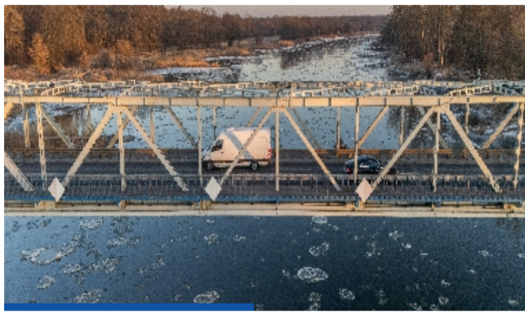
Budowa nowego mostu ma zakończyć się w październiku 2029 roku
