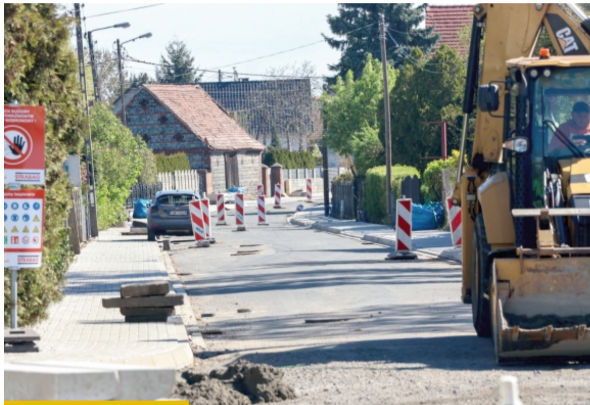
Zaawansowanego etapu pracy w ul. Chrobrego z ul. Zielonogórskiej nie widać
