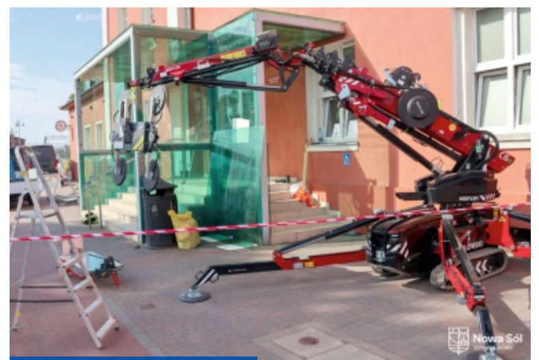
Maszyna zwana „pajakiem” jest w stanie podnieść szyby ważące nawet setki kilogramów
