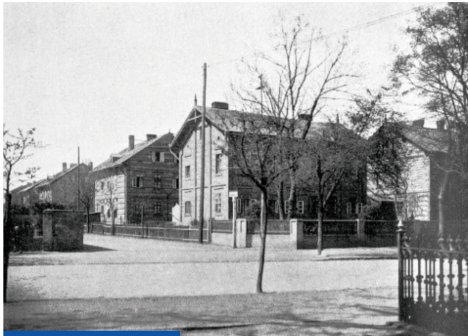
Huta Krausego dla swoich pracowników wybudowała prawie 150 mieszkań. Na zdjęciu Kolonia Hutnicza
